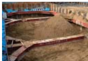
旧船川製油所における埋戻し工事
