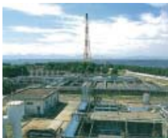
排水処理設備
