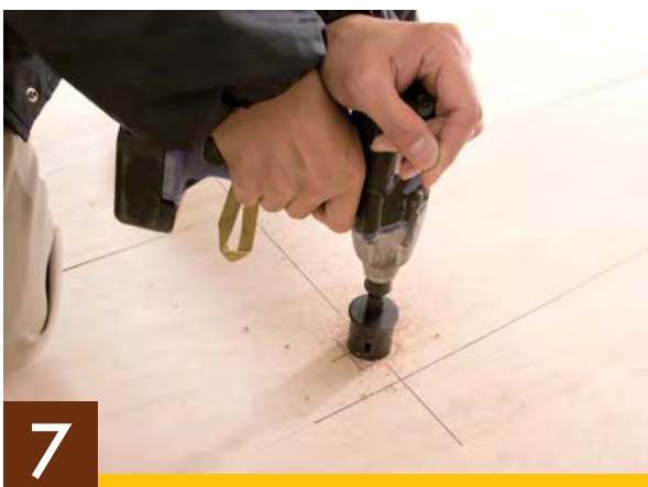
ヒーター口出し線部の下地合板に配線用の穴を開けます
